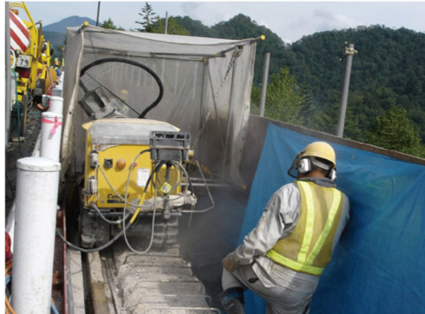
ロボットによるはつり
